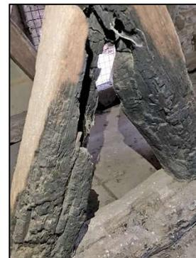
a subi un incendie qui a totalement détruit la charpente. Sur la plateforme supérieure, une structure de bois très ancienne a survécu au sinistre, mais en porte encore les stigmates carbonisés.
